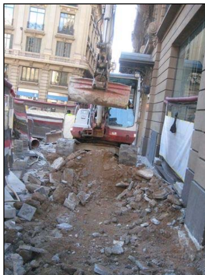
Durant els treballs de rebaix a la vorera davant el núm. 49 de la Via Laietana
