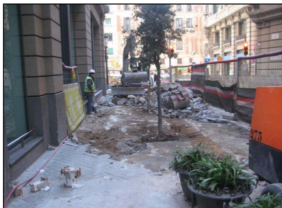
Rebaix del c/Comtal sobre el núm. 37 vista NE
