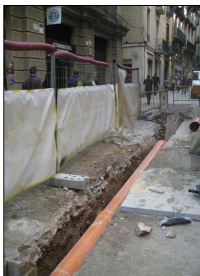
Vista SE de la rasa 1200 amb el tub de PVC
