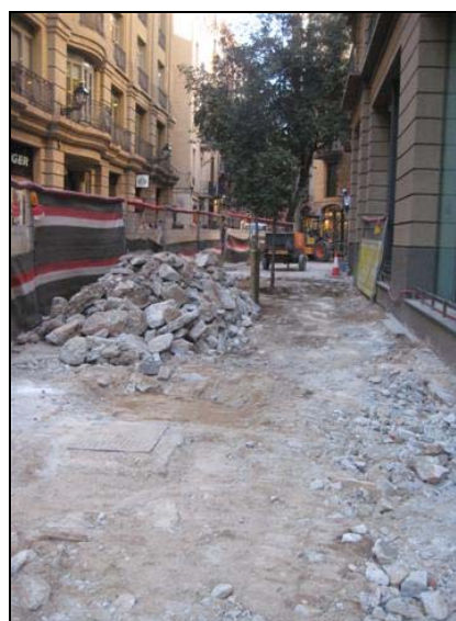
Rebaix del c/Comtal sobre el núm. 37 vista SW
