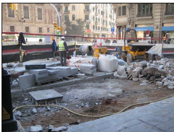
Rebaix a la vorera davant el núm. 49 de la Via Laietana
