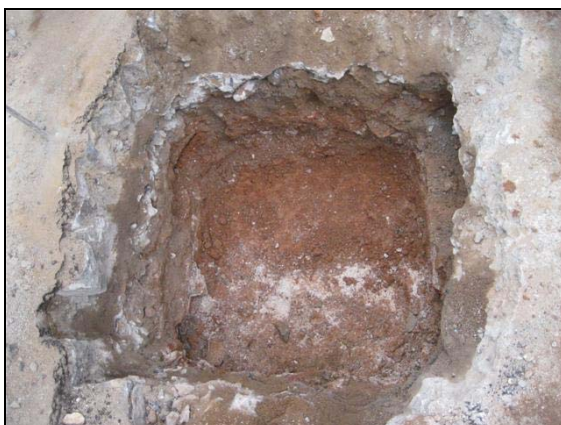
Cala 700 un cop desmuntades les estructures
