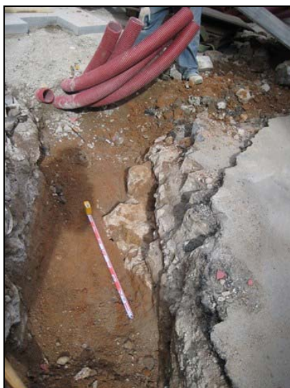
Vista NW de la fonamentació UE 1105
