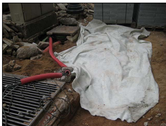
Protecció de les restes amb geotèxtil
