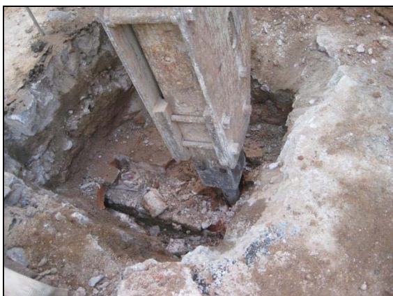
Desmuntant les estructures UE 705 i 706
