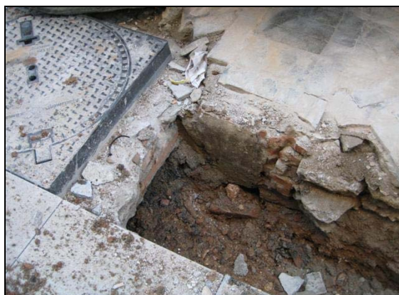
Vista de l'estructura UE 1304
