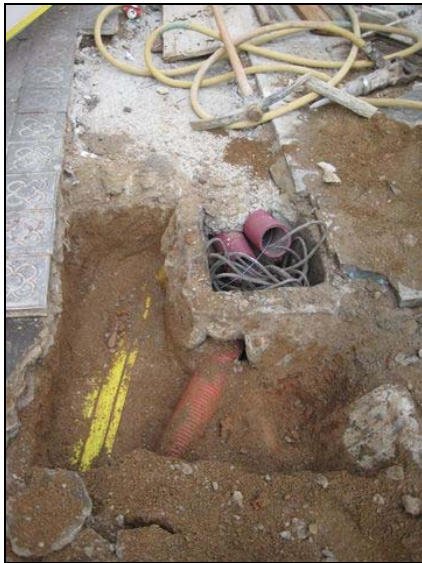
Zona rebaixada per a connectar cables a una arqueta
