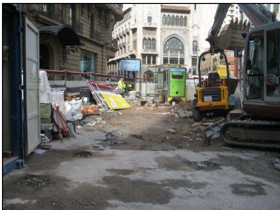
Zona rebaixada a la calçada davant el núm. 49 de la Via Laietana
