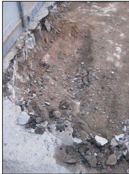
Zona rebaixada per a passar els tubs
