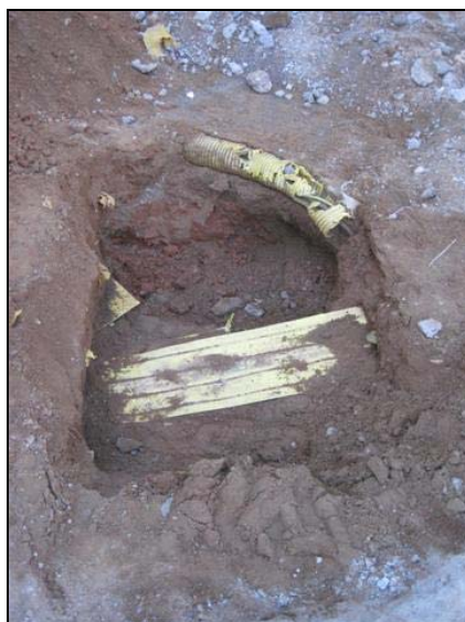
Vista de la cala 600 un cop finalitzat el rebaix
