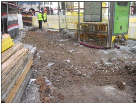
Detall d'aquest rebaix a la zona de la calçada on s'observa un nivell de sauló i runa sota les llambordes
